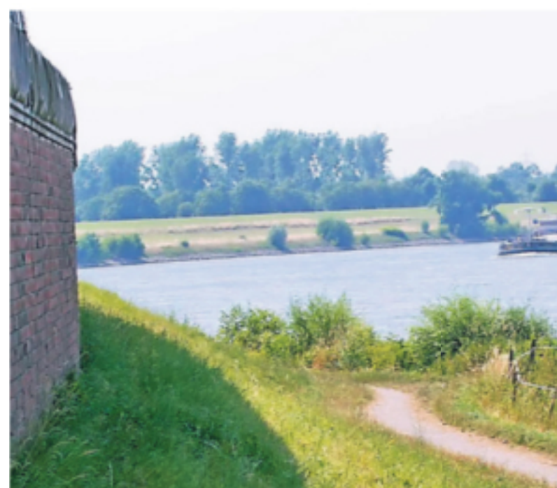
Eine erhöhte Deichmauer soll – wie hier in Stürzelberg – Dormagen vor Hochwasser schützen. ARCHIVFOTO: ATI
